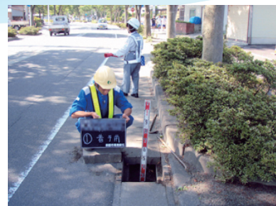
道路側溝清掃
